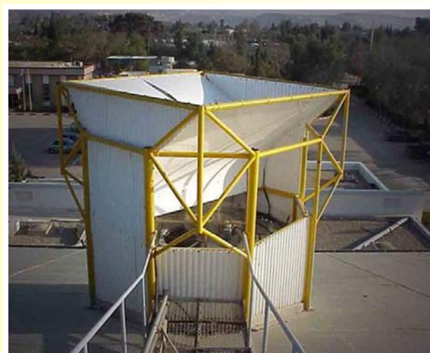
איור 24.18. הכונס בראש מגדל הקירור בבניין המינהלה, המכונים לחקר המדבר, קריית שדה בוקר של אוניברסיטת בן גוריון.
