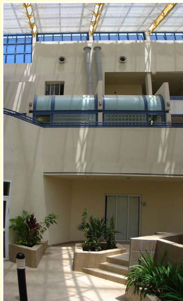
איור 25.3. מבט מתוך החצר המקורה השקועה: תעלות אוויר בחממה לחימום בחורף, ורשתות מתחת לקירוי השקוף להצללה בקיץ.
