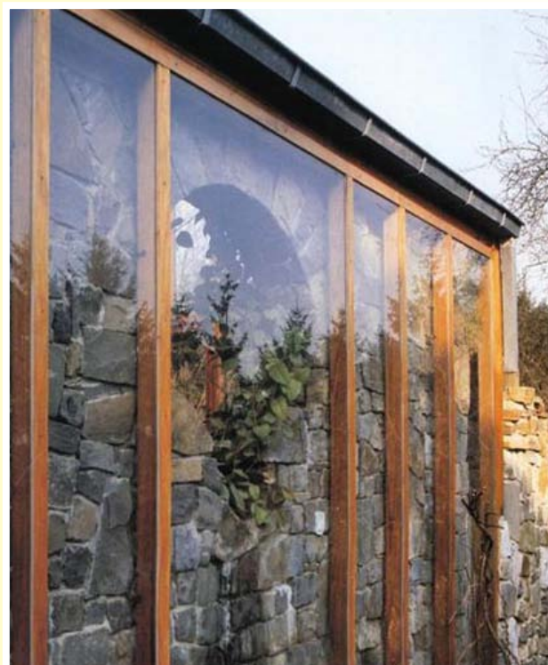
איור 24.8. חתקנת זיגוג מהצד החיצוני של קיר האבן על מנת להפוך אותו לקיר אוגר.
