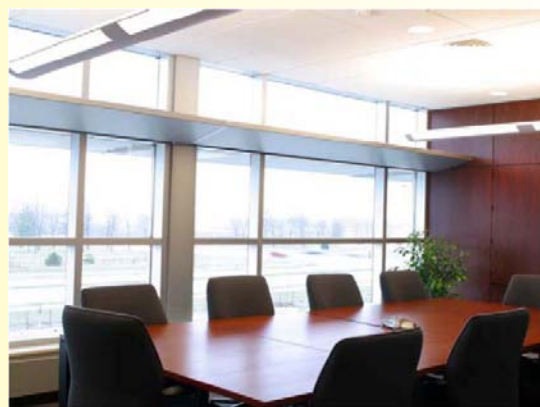
איור 23.6. מדף אור פנימי בחדר ישיבות. מבעד לחלון ניתן להבחין גם במדף חיצוני.
